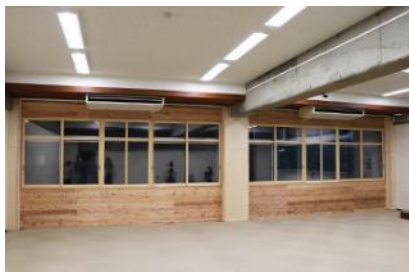
【断熱材設置後の教室】
