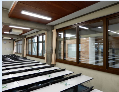
421教室 内窓断熱（Low-e複層ガラス）施工後
