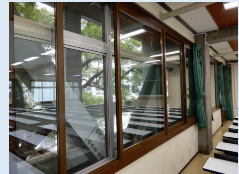
421教室 内窓断熱（Low-e複層ガラス）施工後
