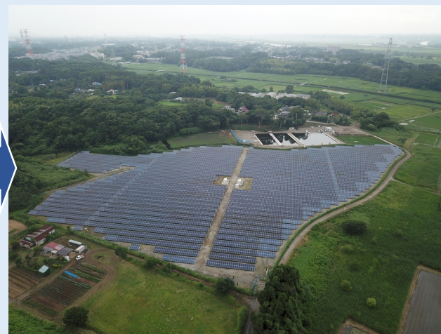
増設後の発電所
