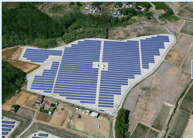
増設前の発電所
