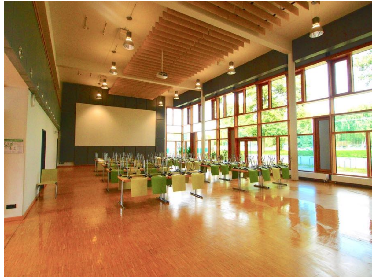
食堂兼多目的ホールは、外付けブラインドではなく瞬間調光ガラスを採用（写真：金田真聡）
