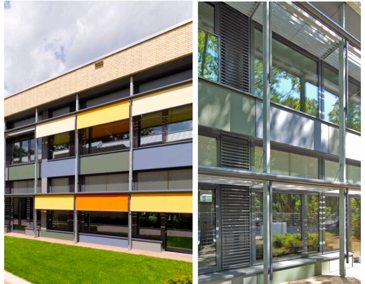
左の写真は垂直の日射遮蔽材、右の写真は水平の日射遮蔽材（写真：IBUS Architekten und Ingenieure GbR）
