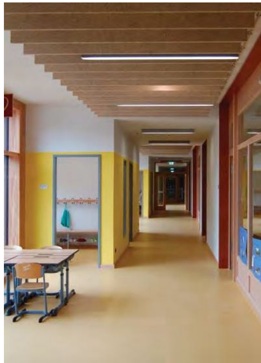
センサー付き廊下照明
