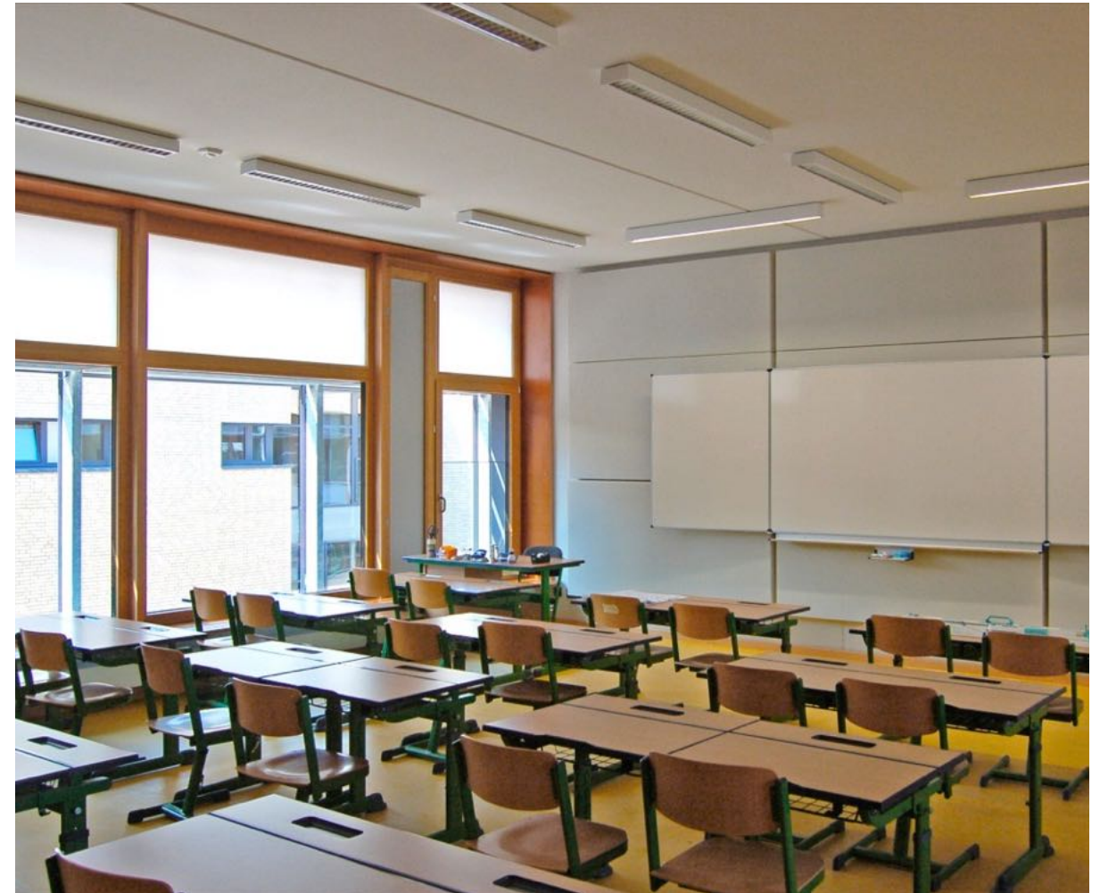
個別にオン・オフ可能な教室内の照明（写真：IBUS Architekten und Ingenieure GbR）
