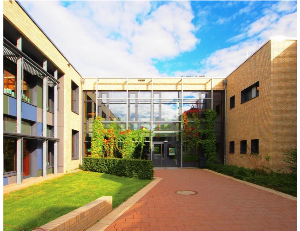
教室棟間の中庭。棟ごとに心地よいスケールの外部空間を配置している（写真：金田真聡）
