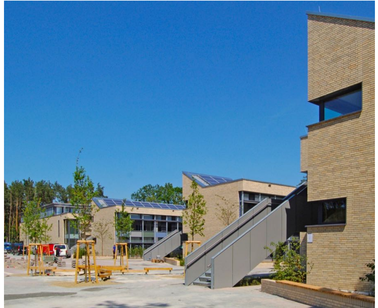
建物西側ファサード。建物外壁U値は0.13。教室等の屋根には太陽光発電が見える（写真：IBUS Architekten und Ingenieure GbR）
