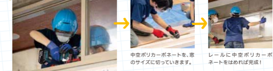
窓の内側に、二重窓用のレールを固定します。 中空ポリカーボネートを、窓のサイズに切っていきます。 レールに中空ポリカーボネートをはめれば完成!
