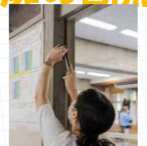
隙間風を防ぐモヘアアールを貼って断熱!
