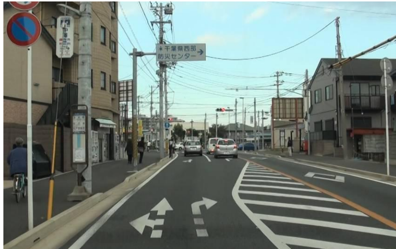
図 4.2.4 「平成 22 年の市川松戸線下り側 右折レーン増設後」
