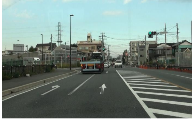
図 4. 2. 6 「平成 22 年の市川松戸線下り側 東京外郭環状道路付近」
