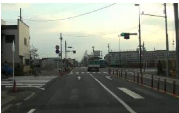
図 3.2.9 「平成 22 年 市川松戸線 上り 国道 298 号線(東京外郭環状道路)との合流地点」(参考文献【4】より引用)
